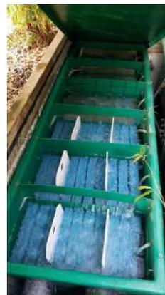
La filtration de Luc : Préfrite à grille, superbéads, multichambre, ozone du printemps à l'automne.
