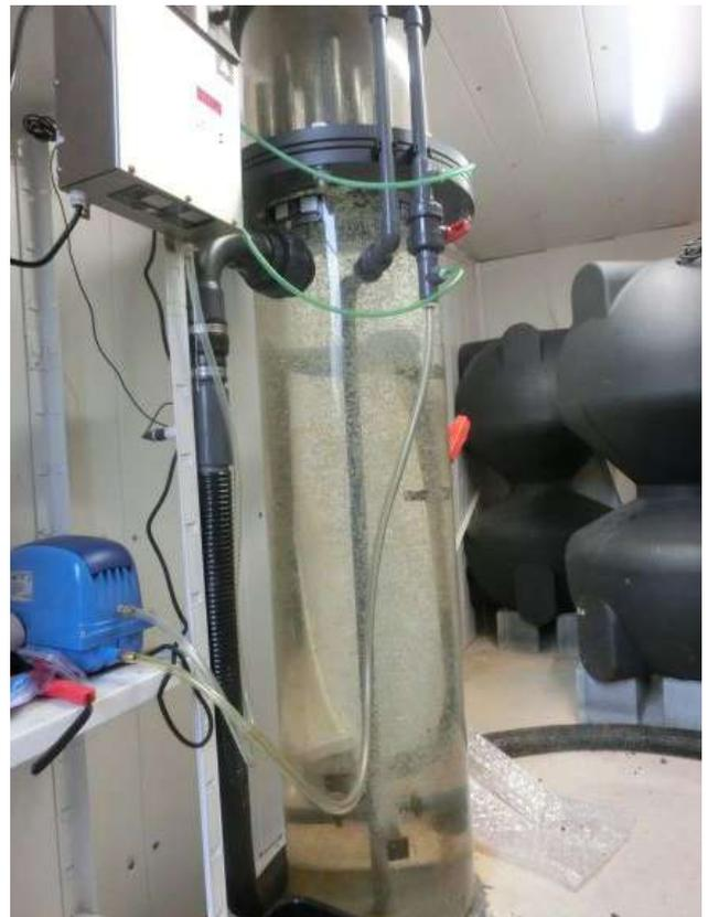
**Dans cette installation, 20% de l'eau passe chaque heure dans le réacteur, et ce réacteur, géré par le contrôleur, ne reçoit de l'ozone qu'en cas de besoin. On est très loin d'une eau stérile, elle est simplement contrôlée... et maîtrisée.**
