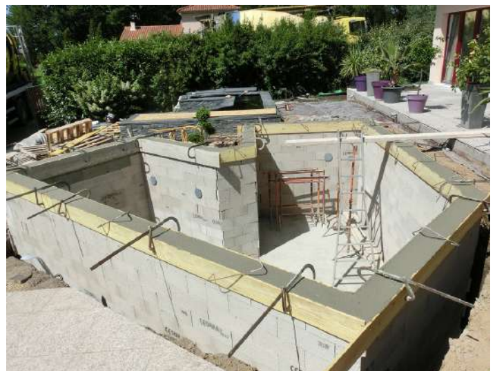
Coulage terminé. Bière à suivre.
