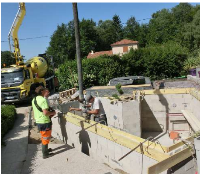
Coulage (en grande pompe).
